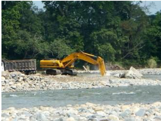
Foto 8: Extracción materiales directamente del río, pocos metros toma de agua La Joyita (junio, 2008).
